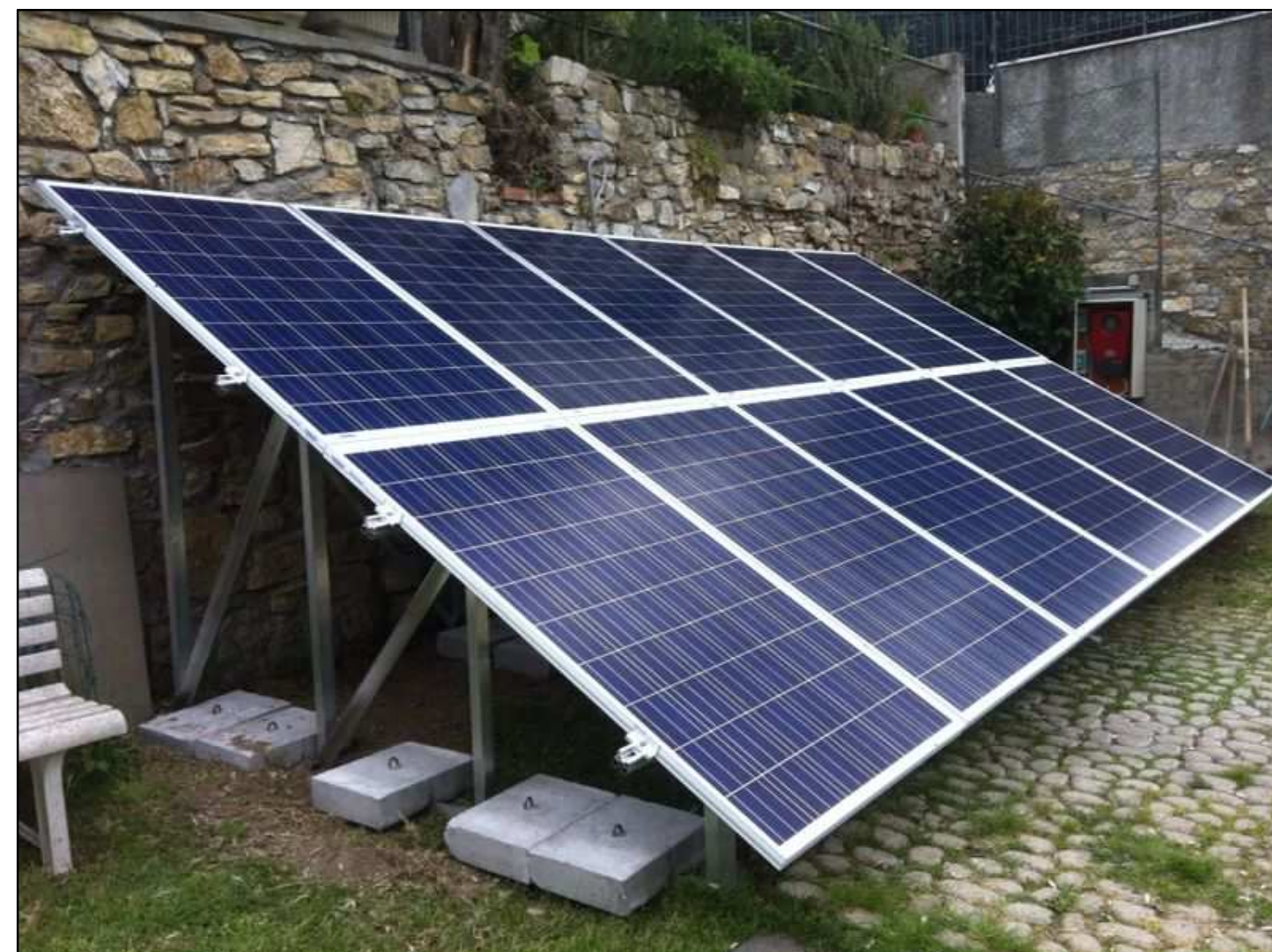
FOTO 2 ESEMPIO STRUTTURA A VELA UNICA PER 2 FILE DI MODULI IN VERTICALE
