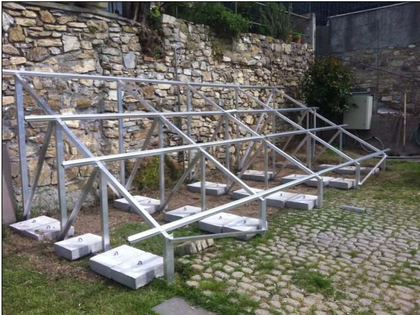
FOTO 1 ESEMPIO STRUTTURA A VELA UNICA PER 2 FILE DI MODULI IN VERTICALE
